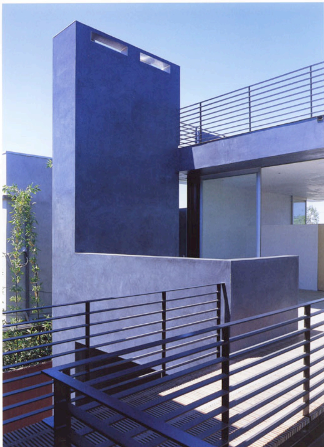
View toward patio on second floor 二階からパティオ方向を見る
